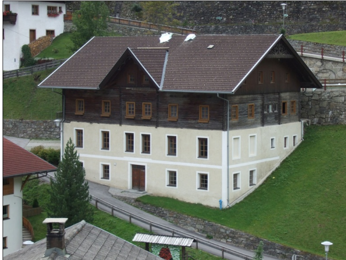
Schule Außervillgraten (c) OSG und Gemeinde Außervillgraten
